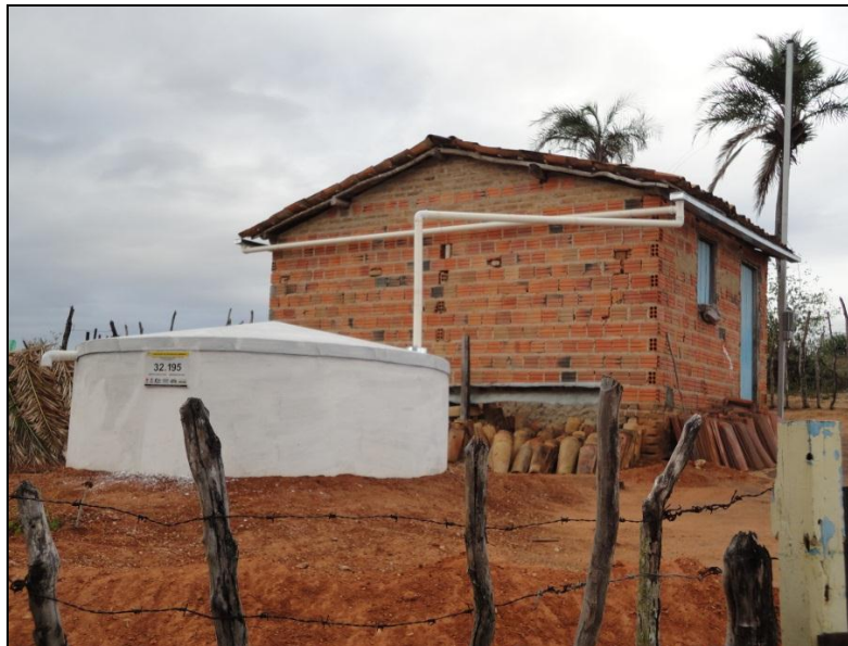
Figura 5: Cisterna para armazenamento de água para consumo humano
