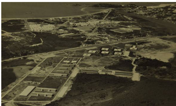
Figura 26: Campus Goiabeiras após a construção das edificações
