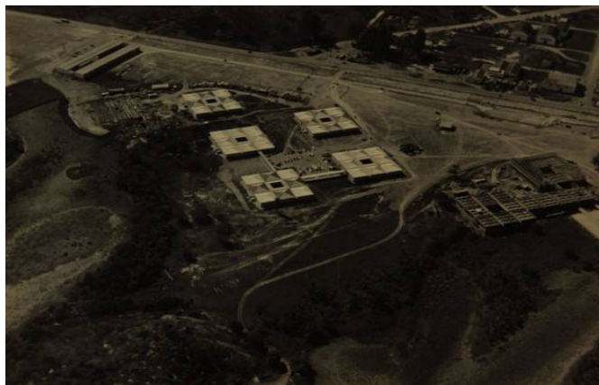
Figura 28: Construção do CEMUNI VI - Campus Goiabeiras/UFES
